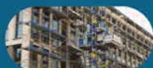
Rehabilitación de edificios
