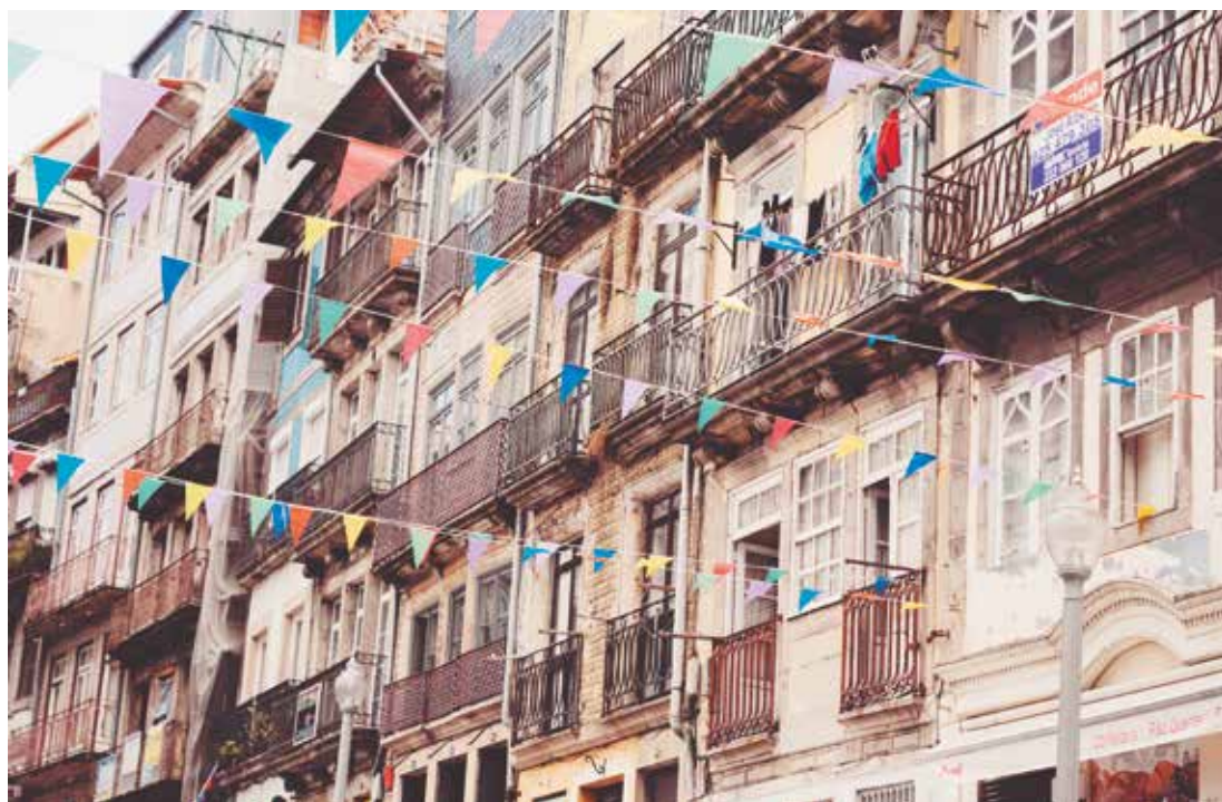
Fachadas de las viviendas: antiguas, señoriales y sobre todo con mucho encanto.
